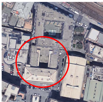
Figura 2.2 - Vista satellitare dell'edificio (Fonte: Google Earth)
