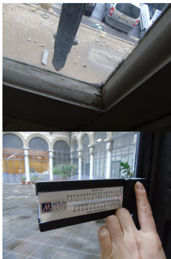
Figura 4.4 - Particolare dei serramenti
