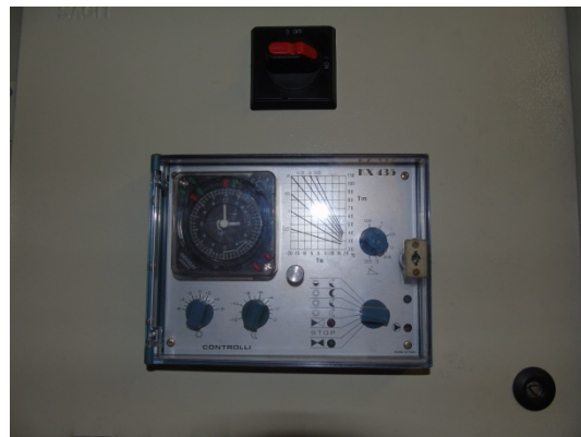
Figura 4.8 – Centralina di regolazione curva climatica
