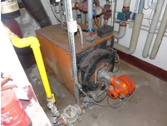
Figura 4.11 - Generatore di calore – IVAR WS/AR-290
