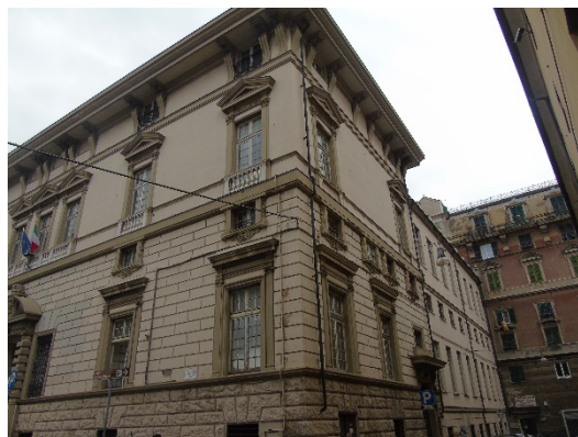
Figura 1.1 - Vista della facciata esposta a Sud Est
