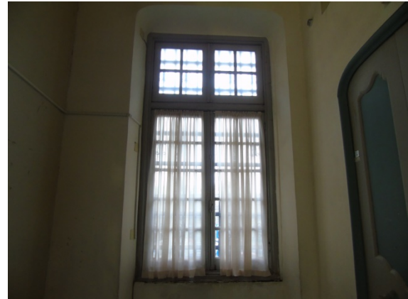
Figura 8.1 - Particolare serramenti da sostituire.
