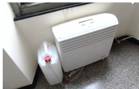
Figura 4.14 – Particolare del climatizzatore senza unità esterna in formato consolle UNICO easy HP.
