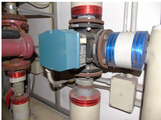
Figura 4.7 - Particolare della valvola miscelatrice
