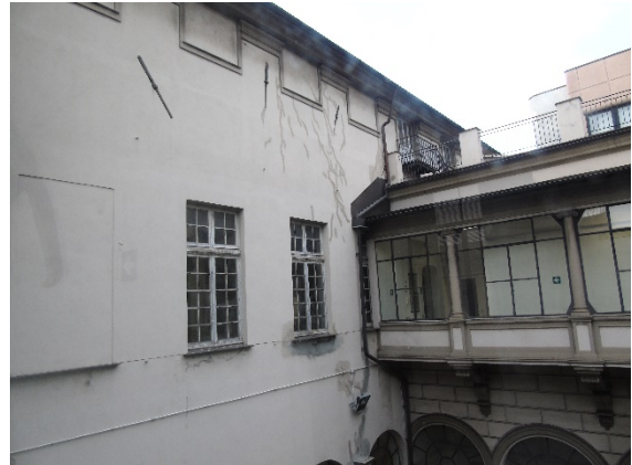
Figura 4.2 - Particolare della copertura
